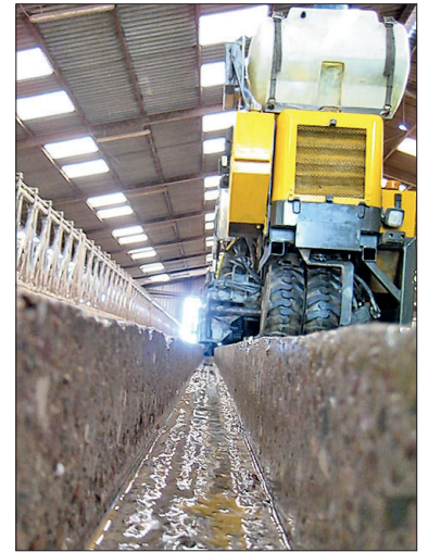
La machine découpe une rainure nette et rectiligne en un seul passage.
